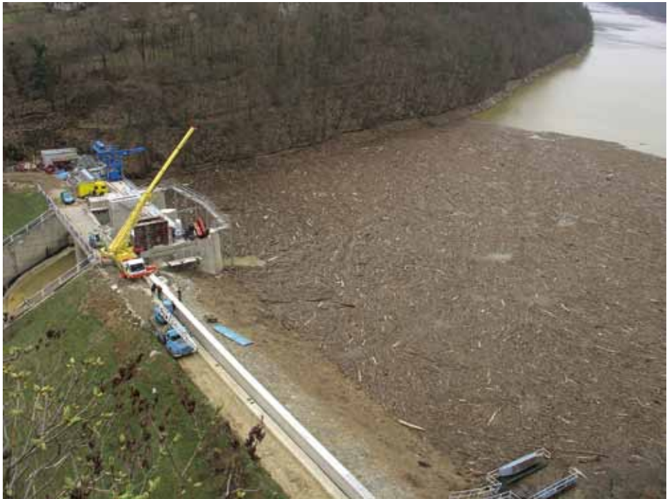
Obr. 1. Dřevní materiál naplavený do přehradní nádrže Znojmo na řece Dyji během povodně v březnu 2006. Foto Pavel Kožený (VÚV TGM).
