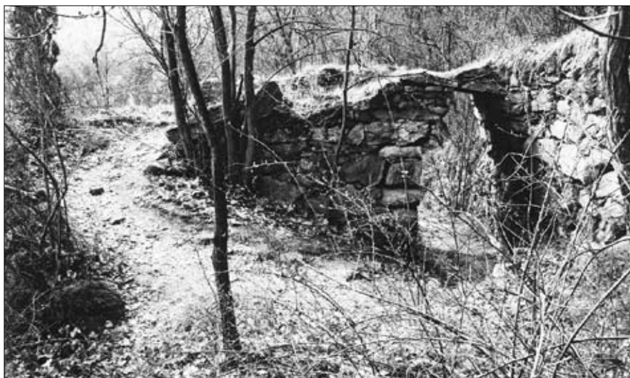
Kamenná smýčka – kombinace tunelu a mostku – na cestě z Gránic na Hradiště
