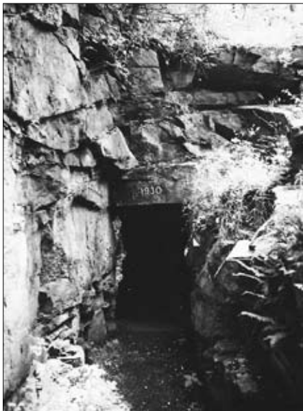
Tunel ve skále na „Cestě 24. pluku“ z roku 1930
