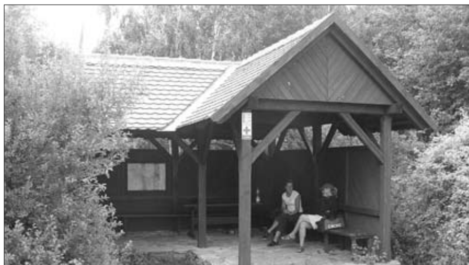
Přístřešek na křižovatce Keply - velmi frekventované místo na cestě z Čížova do Hardeggu.
