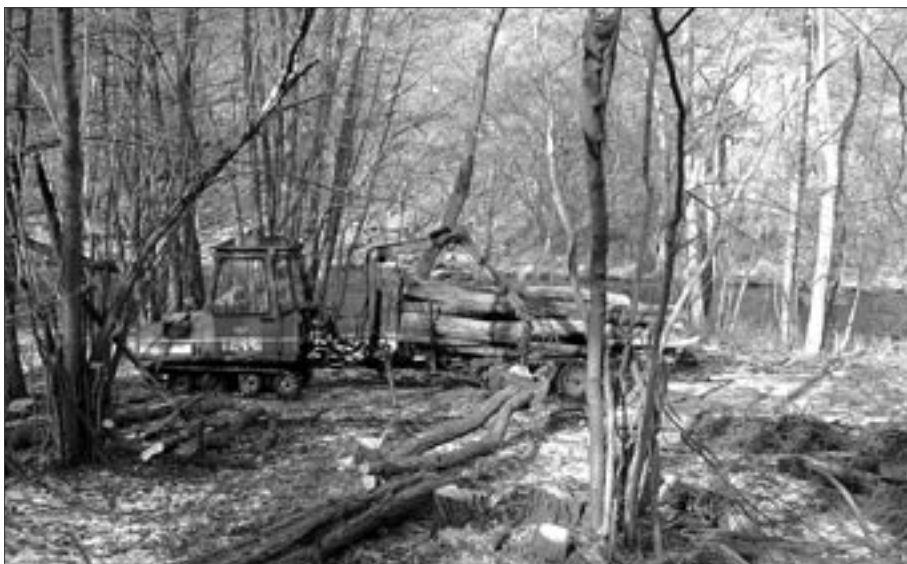
Pásová souprava TERRI při vyklízení dřevní hmoty
