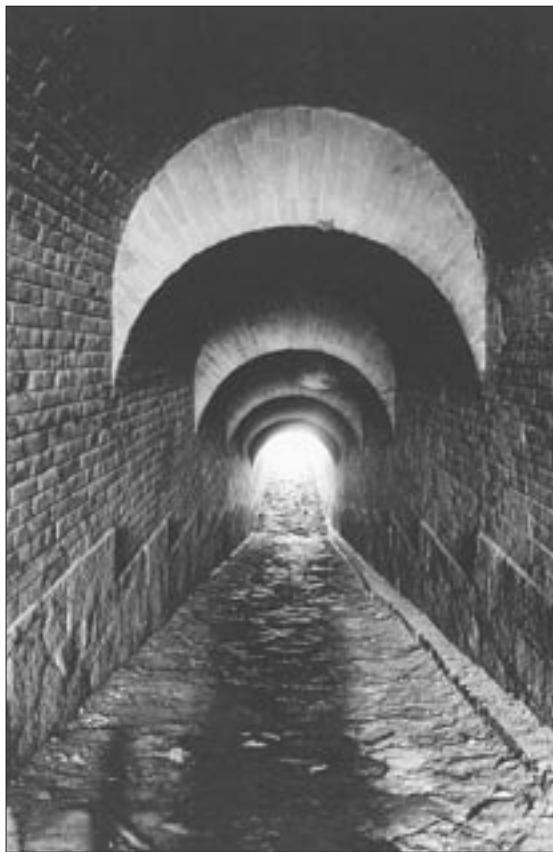
Stupňovaná klenba odvodňovacího tunelu mezi Znojmem a Dyjí
