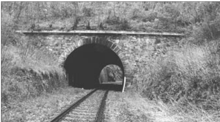
Tunel pod Pražskou ulicí ve Znojmě
