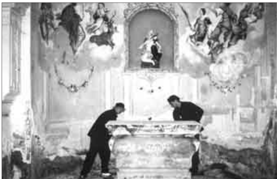
Interiér kaple během rekonstrukce
