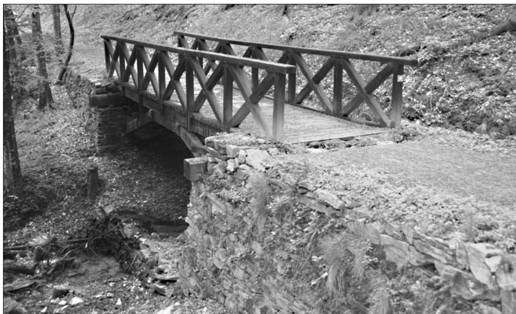
Most Heleny Mniszkové před rekonstrukcí
