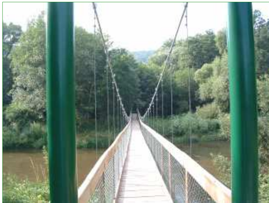
Ukázka zdařilého technického díla – lávka pro pěší přes Dyji
